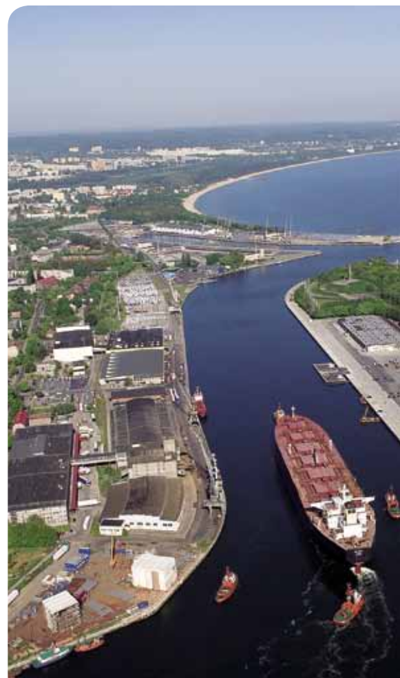
> Kanał portowy w Porcie Wewnętrznym Fot. Zarząd Morskiego Portu Gdańsk SA
