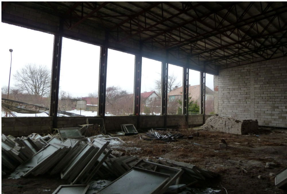
Zdjęcie nr 3 – Konstrukcja nośna Sali gimnastycznej – rozstaw słupów stalowych dwugaleźniowych.
