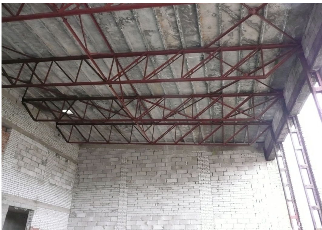
Zdjęcie nr 6 – Układ konstrukcyjny Sali gimnastycznej – widok od dołu wiązarów kratowych
