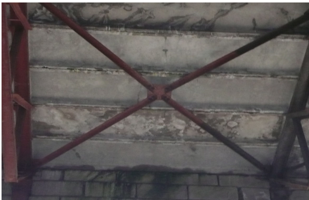
Zdjęcie nr 10 – stężenia połaciowe wiązarów kratowych – widok od dołu
