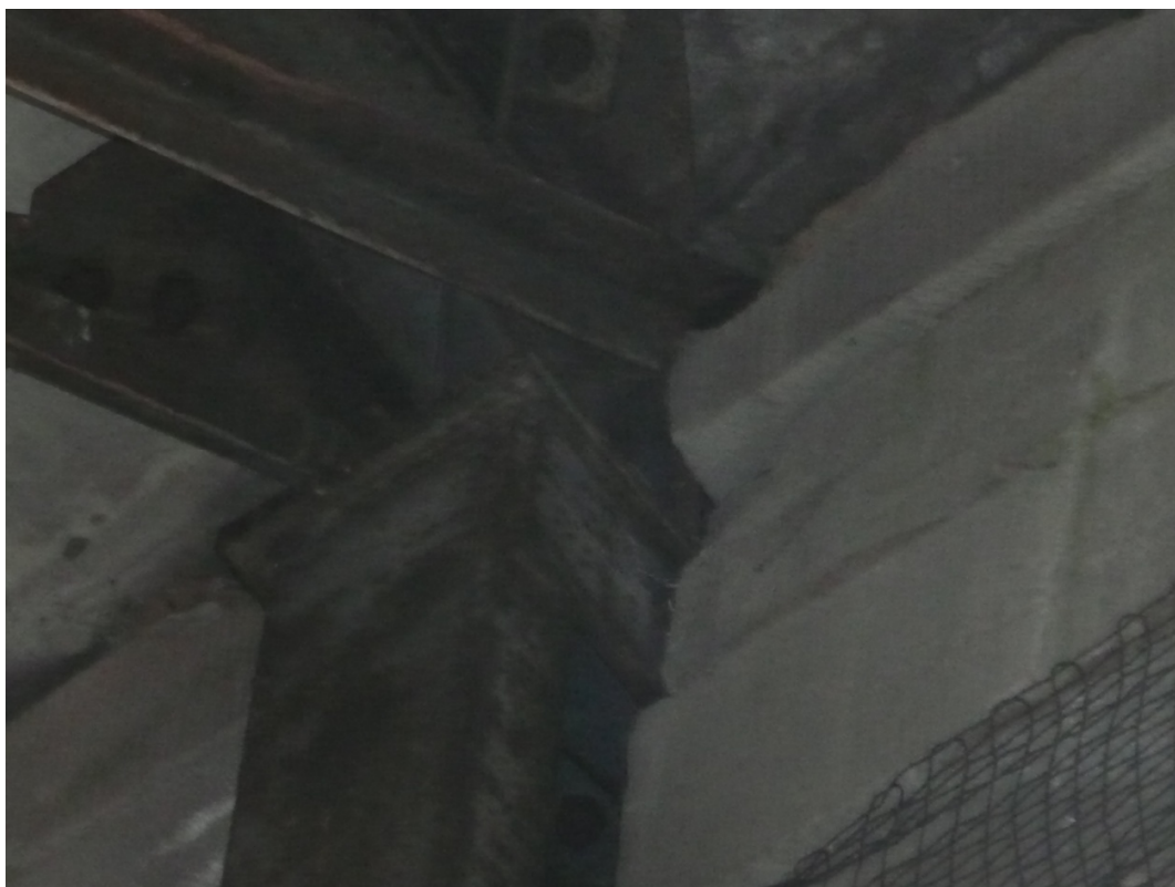
Zdjęcie nr 7 – oparcie wiązara kratowego na słupie stalowym
