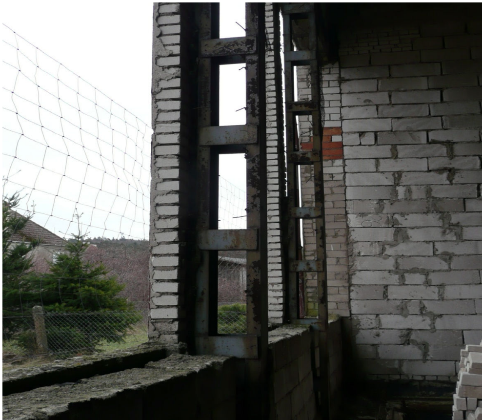
Zdjęcie nr 5 – słup stalowy widok z boku.
