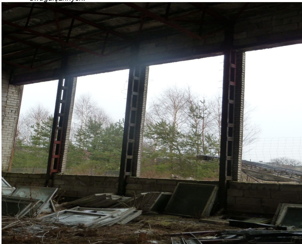
Zdjęcie nr 4 – Słup stalowy z 2xceownik 160mm połączony blachą 140x280x5– widok z bliska.
