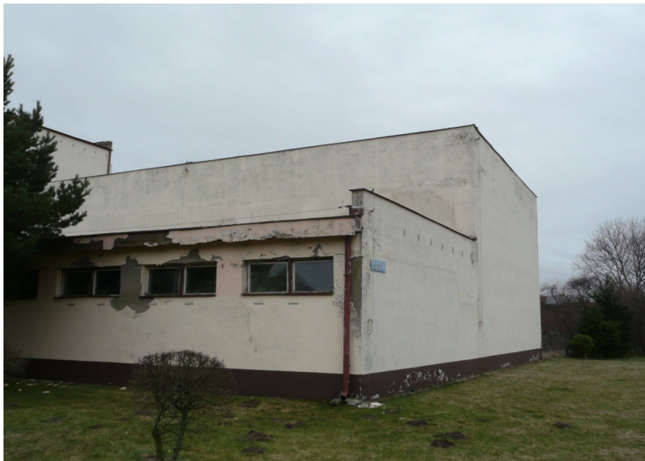
Zdjęcie nr 1 – Układ konstrukcji nośnej Sali gimnastycznej – widok od środka..
