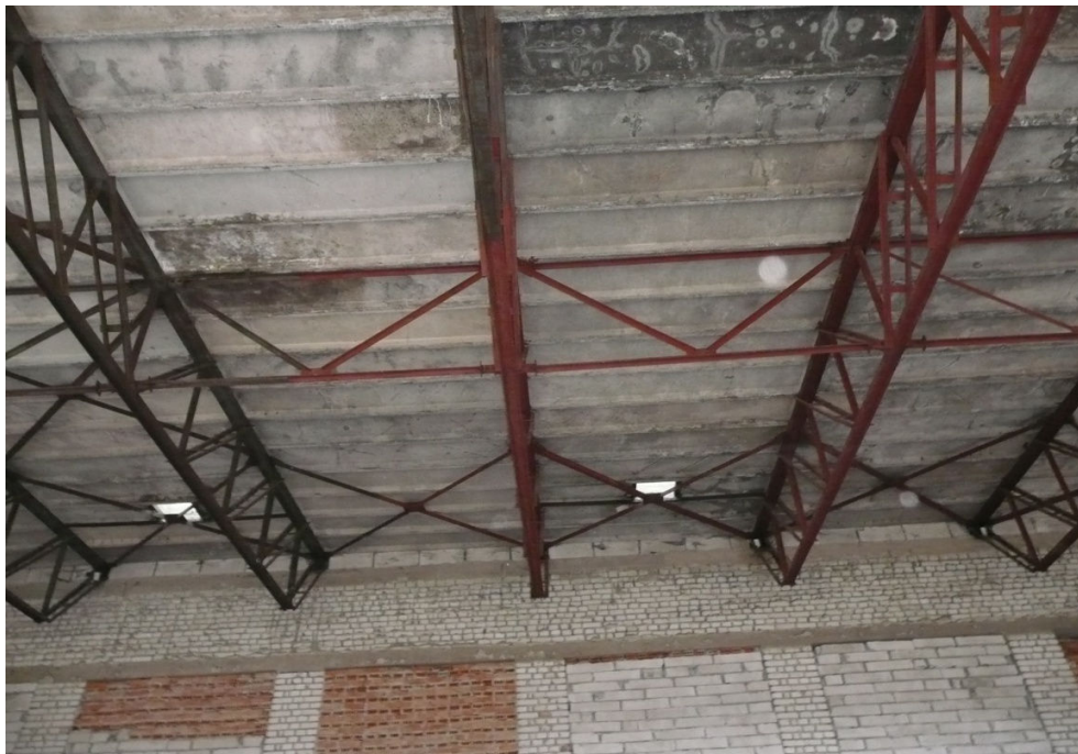
Zdjęcie nr 9 – stężenia pionowe wiązarów kratowych – widok od dołu
