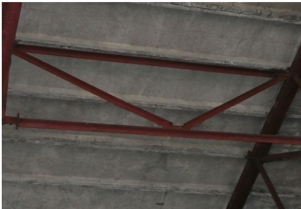
Zdjęcie nr 8 – stężenia pionowe wiązarów kratowych – widok od dołu
