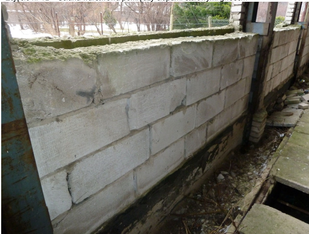
Zdjęcie nr 12 – Ściana warstwowa pomiędzy słupami stalowymi gr.38cm
